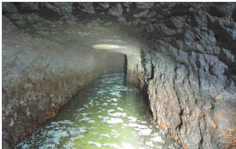
Figura 8 – Göreme (Cappadocia). Cunicolo-cisterna con funzione mista di trasporto e accumulo idrico, a pelo libero (Foto A. Bixio)
