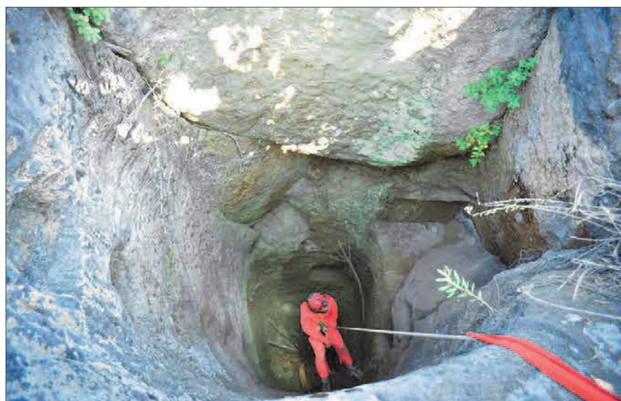
Figura 4 – Karakum, Ahlat (Lago Van). Il pozzo-neviera, a fondo cieco, è dotato di pedarole (Foto A. Maifredi)
